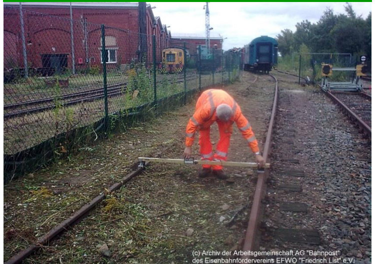
Beräumungsarbeiten und Gleisvermessung bei der verwilderten stillgelegten Werksbahnanschlussgleise des ehemaligen Raw Zwickau. Das hier wieder Bahnbetrieb ermöglicht wurde, wagten viele nicht zu glauben. Bilder © André Ackermann
